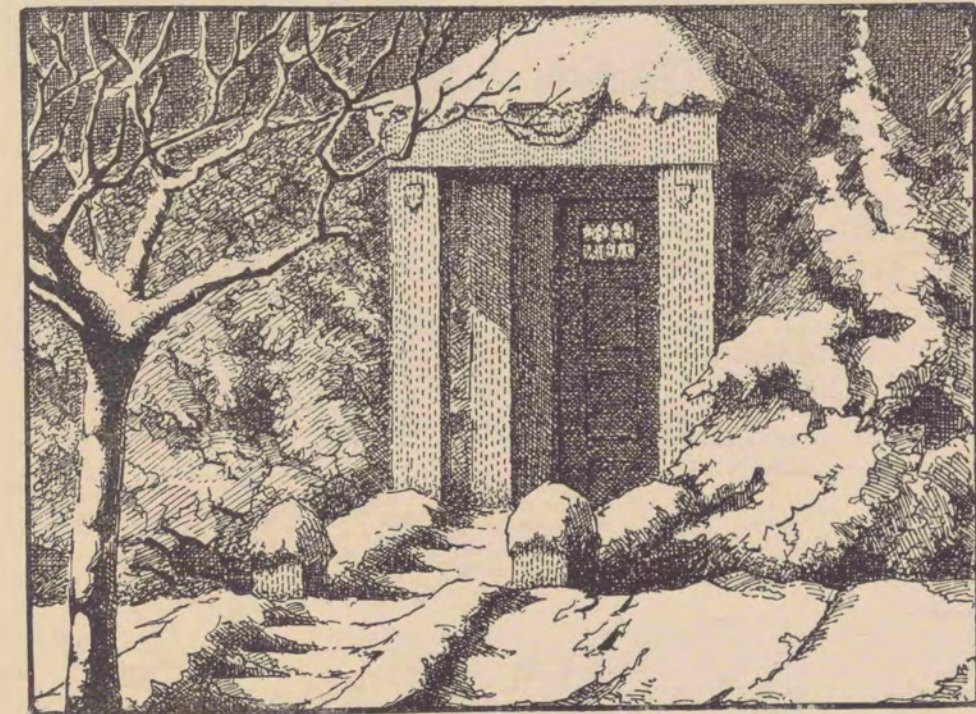
Eingang zur Turnhalle
