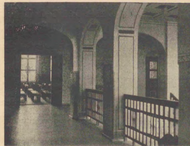
Flur im zweiten Stockwerk der Lessingschule
